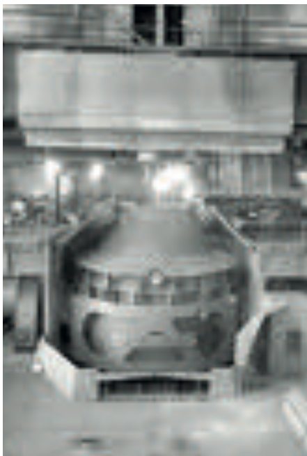
De nieuwe 100-tons converters van Demag (1961)
