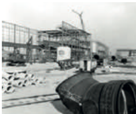
Bouwfase Blok- en Knuppelwalserij
