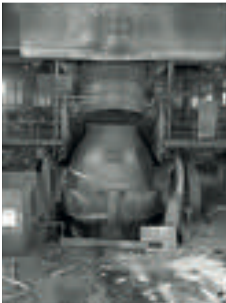
Eén van de oorspronkelijk geplaatste 60-tons converters
